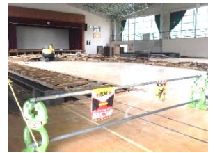
改修工事が始まった体育館の内部
